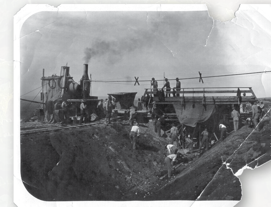
Constructing an irrigation ditch. Construcción de una zanja de irrigación.
