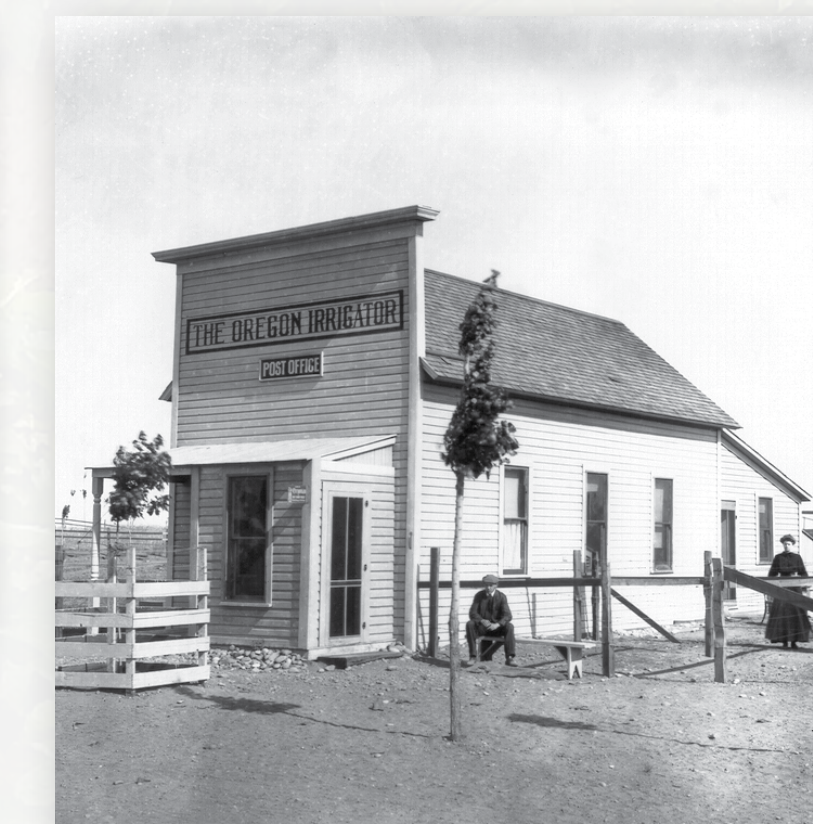
The post office and offices of the local newspaper, the Irrigator. La oficina postal y las oficinas del periódico local, “The Irrigator”.
